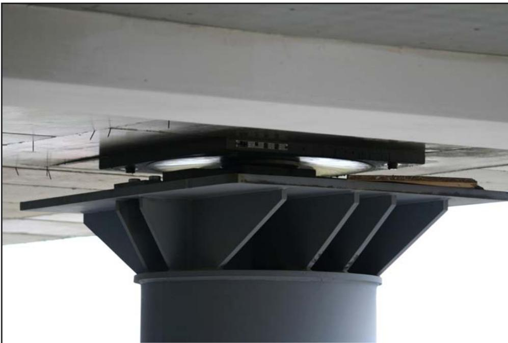
**Esempio di Isolatori sismici a pendolo**
