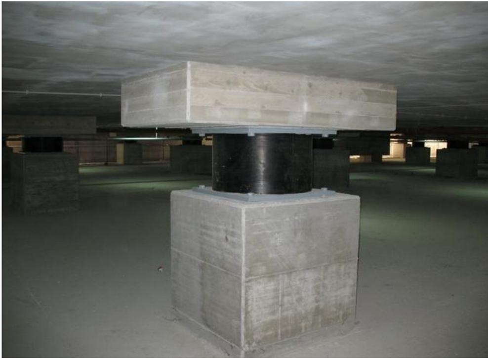
**Esempio di Isolatori sismici elastomerici**
