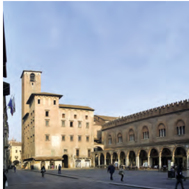
PALAZZO DEL PODESTÀ (MN) Recupero, valorizzazione e riuso funzionale
