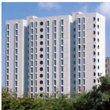
ISPEI E COMUNE DI VERONA Sistema costruttivo industrializzato per edilizia residenziale a Verona
